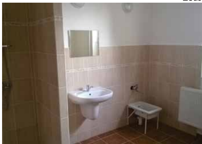
Rekonstrukce sociálních prostor
